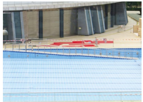
Eine Rampe führt ins Schwimmbecken – barrierefrei
