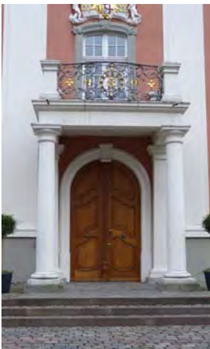
Abb. 121 und 122 Die schwere bauzeitliche Außentür steht zu Öffnungszeiten offen, den Wetterabschluss bildet dann die selbstöffnende Glastür im Gebäudeinneren.
