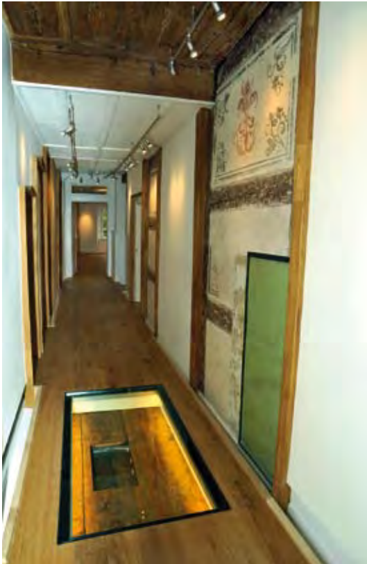
Abb. 109 Die unterschiedlichen Bodenniveaus wurden durch einen neuen durchgängigen Holzfußboden unter Erhaltung des Bestandes barrierefrei gestaltet. Wie groß die Höhenunterschiede im Bestand waren, kann man an kleinen „Schaufenstern“ in den neuen Flurböden betrachten.
