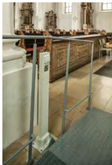
Abb. 70 und 71 Rampen in Innenräumen sollten im Zusammenhang mit selbstöffnenden Türen so geplant werden, dass die Anfahrt und der Öffnungs- und Schließtakt zeitlich optimal aufeinander abgestimmt sind. Der Taster zur Türöffnung ist im Rottweiler Prediger seitlich zur Rampe aufgestellt, wodurch eine gute Bedienbarkeit gewährleistet ist.
