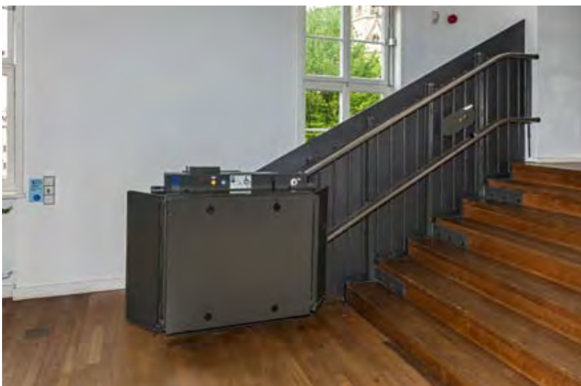
Abb. 73 Auch beim Treppenlift im Uracher Schloss ist die Traglast begrenzt. Neben einem hohen Wartungsaufwand muss sich jeder Bauherr darüber im Klaren sein, dass aus haftungsrechtlichen Gründen Bedienpersonal vorzuhalten ist.
