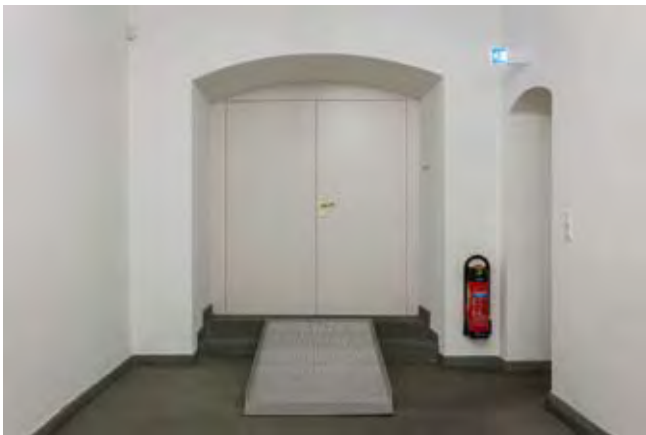
Abb. 68 und 69 Mobile Rampen aus Stahl (Neues Schloss Meersburg) oder Holz (Ulmer Münster) ermöglichen nicht nur den Zugang für Menschen im Rollstuhl, sondern können auch der Versorgung höher gelegener Räume dienen.
