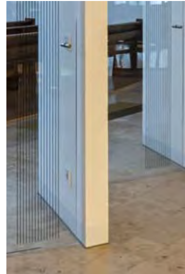
Abb. 137 und 138 Glastüren in der Faltwand sind leichtgängig und mit Sicherheitsmarkierungen versehen. Die Faltwand kann in ihrem Mittelteil geöffnet werden, wodurch ein breiterer Durchgang entsteht.
