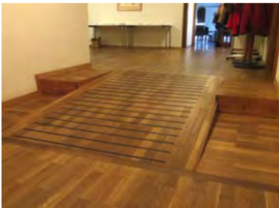
Abb. 59 Hölzerne Rampe in Schloss Beuggen.
