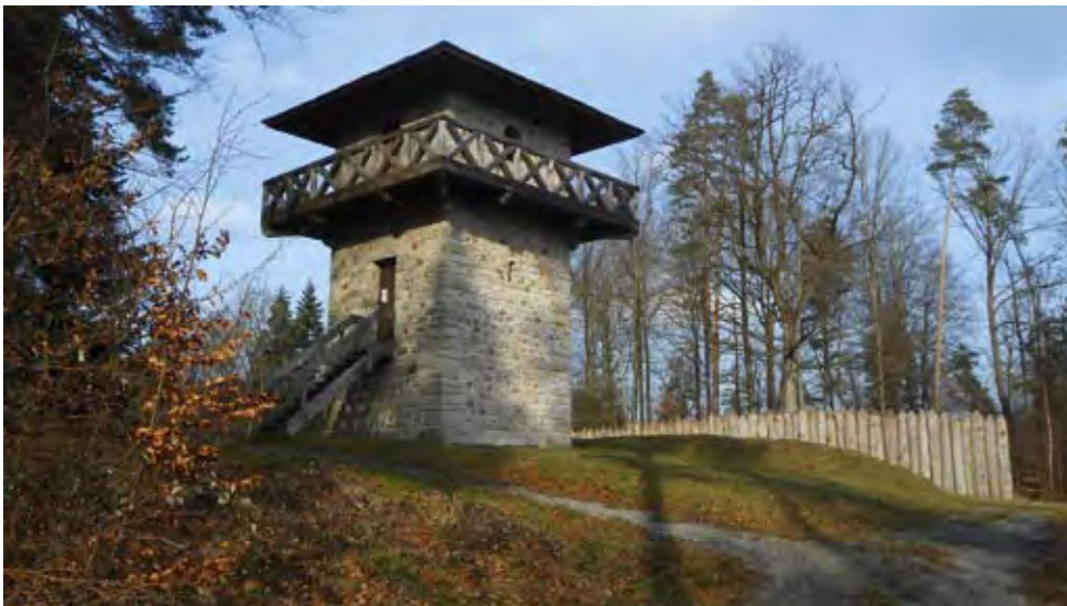
Abb. 154 Rekonstruierter Limesturm bei Grab
