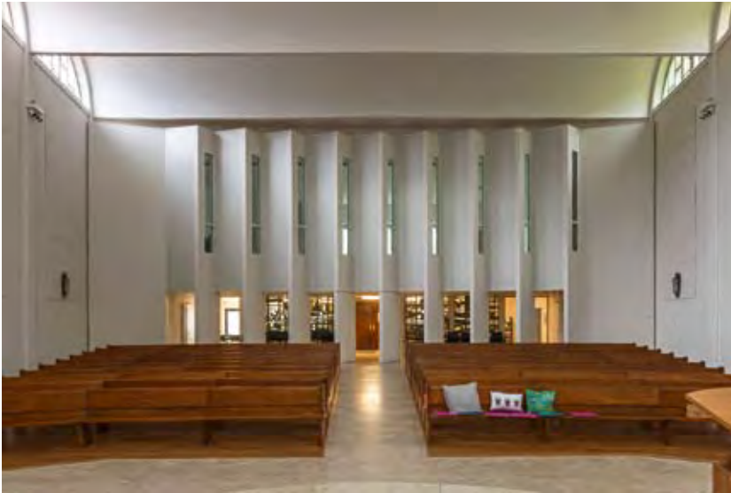
Abb. 137 und 138 Glastüren in der Faltwand sind leichtgängig und mit Sicherheitsmarkierungen versehen. Die Faltwand kann in ihrem Mittelteil geöffnet werden, wodurch ein breiterer Durchgang entsteht.
