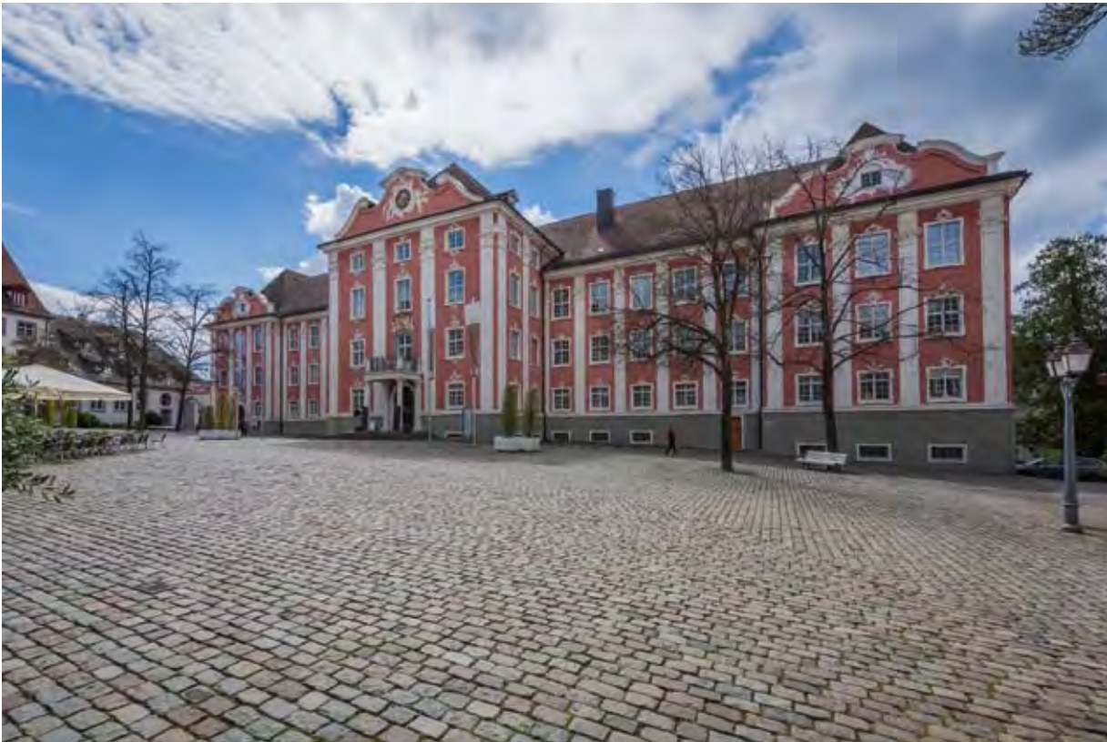
Abb. 116 Ansicht des Neuen Schlosses von Norden.
