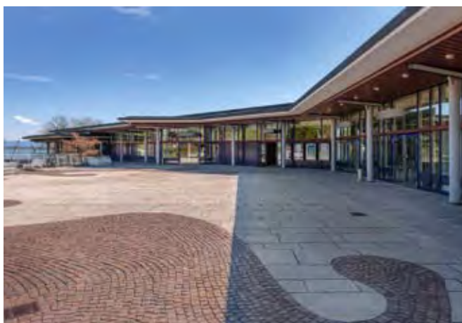
Abb. 143 Eingangsbereich mit ausladendem Vordach
