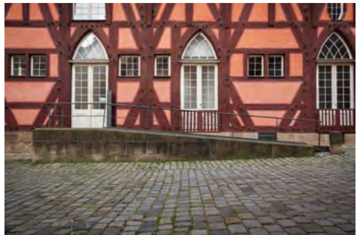
Abb. 36, 37 und 38 Rampe zur barrierefreien Erschließung und Andienung des Alten Esslinger Rathauses. Die Rampe verfügt über seitliche Radabweiser.
