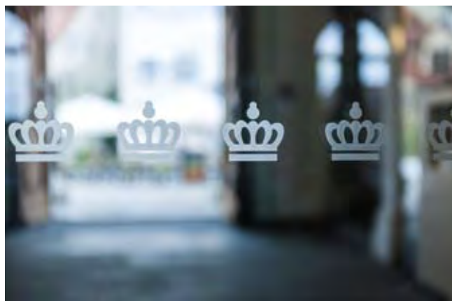
Abb. 53 Glaswand mit Sicherheitsmarkierungen auf Augenhöhe von Rollstuhlnutzenden im Neuen Schloss in Meersburg.
