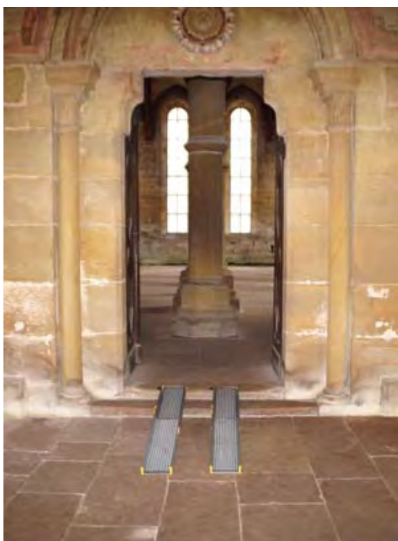
Abb. 12 und 13 Das Refektorium des Klosters Maulbronn ist vom Kreuzgang aus über zwei Stufen erreichbar. Um den Raum auch für Menschen im Rollstuhl zugänglich zu machen, stehen zwei mobile Fahrillenprofile zur Verfügung, die bei Bedarf angelegt werden können.
