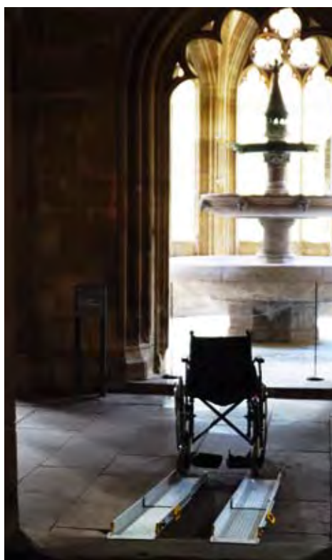
Abb. 12 und 13 Das Refektorium des Klosters Maulbronn ist vom Kreuzgang aus über zwei Stufen erreichbar. Um den Raum auch für Menschen im Rollstuhl zugänglich zu machen, stehen zwei mobile Fahrillenprofile zur Verfügung, die bei Bedarf angelegt werden können.
