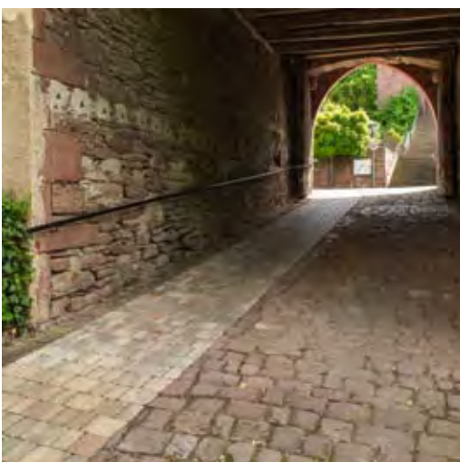
Abb. 23 Der Ersatz von schwer befahr- oder begeharen Pflastersteinen und das Anlegen eines separaten Geh-/Fahrstreifens wie in Tiefenbronn-Mühlhausen (Zugang zum Pfarramt) ist eine denkmalverträgliche Lösung, die sich in besonderer Weise bei Flächen eignet, die ohne ornamentale Gestaltung angelegt sind.
