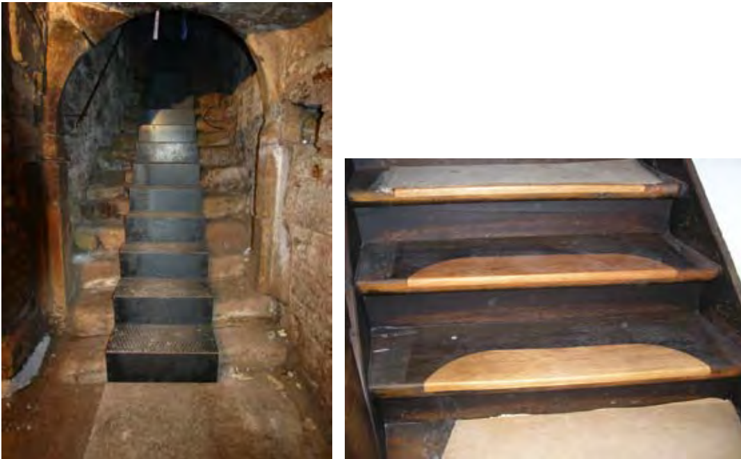
Abb. 64 (oben links) Sofern die Treppe mit ihren Altersspuren erhalten werden soll, eine Reparatur gestalterisch nicht gewünscht oder aus wirtschaftlichen Überlegungen nicht möglich ist, kann auch eine „Überbauung“ der bestehenden Stufen durch eine neue Laufebene als Konzept in Frage kommen. Je nach Raumnutzung sind auch die Anforderungen der Barrierefreiheit einzuhalten.
