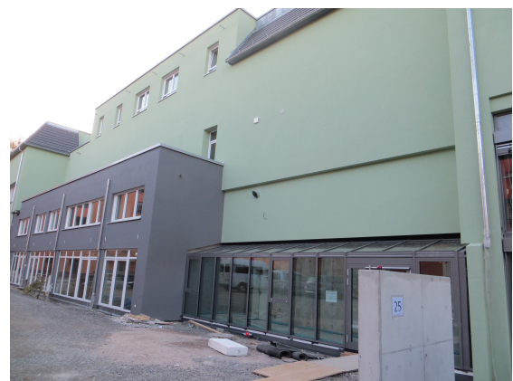
Am Mühlkanal 25 - beim Umzug leuchtete vor allem der Baustellencharme ...
