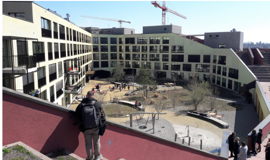
Besichtigung des Kalkbreite Areals
